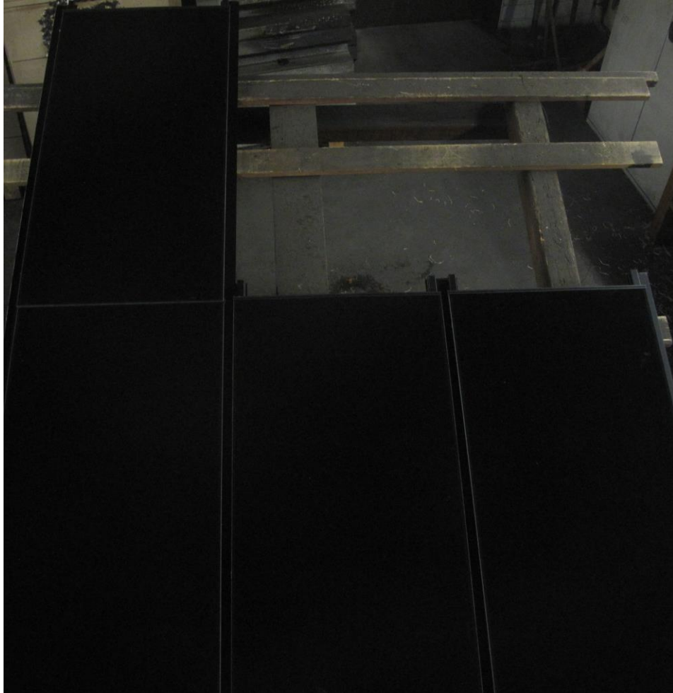
Aufbau der Bedachung mit Aluminium-Verbundplatten Built-up of the roofing-system with aluminium composite plates
